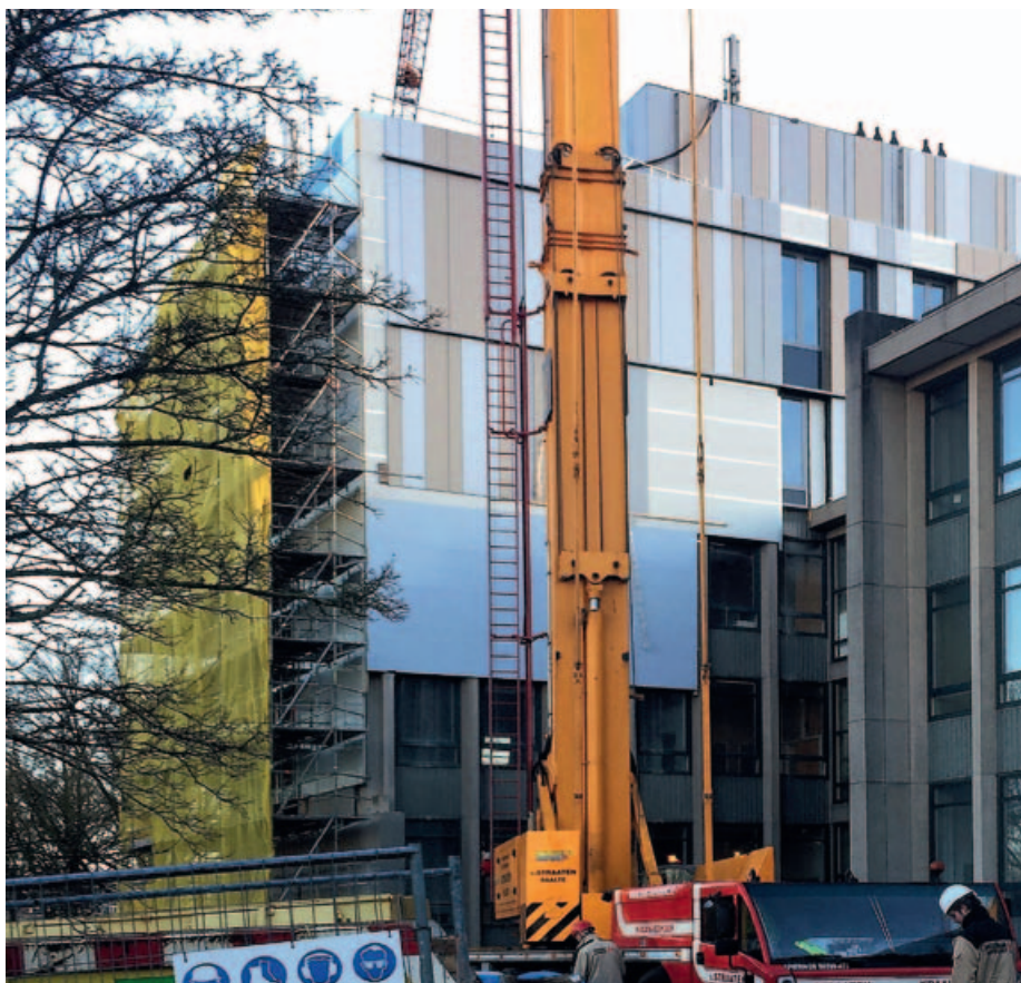
De nieuwe, geïsoleerde gevel is tegen de oude gevel aangebracht.
