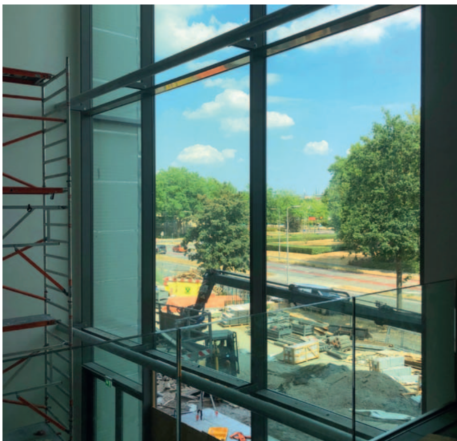
Zicht van binnenuit op de nieuwe vliesgevelconstructie.
